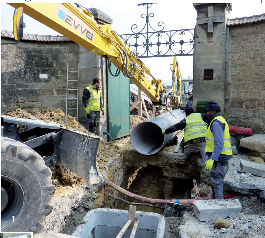
1 - Carrefour rue de l'Eglise/RD190/Cimetière, renforcement réseau eaux pluviales, pose canalisation Ø 800 fonte en remplacement du dalot existant.
