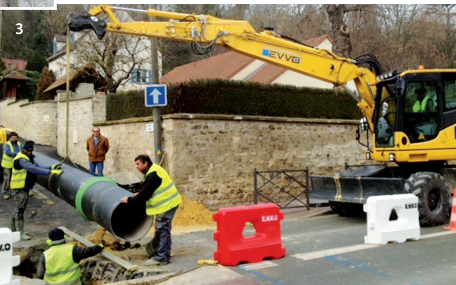
3 - Carrefour Chemin Latéral/RD190, renforcement réseau eau pluviale, pose canalisation Ø 600 fonte en remplacement du dalot existant.
