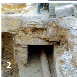
1 - Carrefour rue de l'Eglise/RD190/Cimetière, renforcement réseau eaux pluviales, pose canalisation Ø 800 fonte en remplacement du dalot existant.
