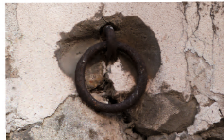
Anneau scellé dans le mur
