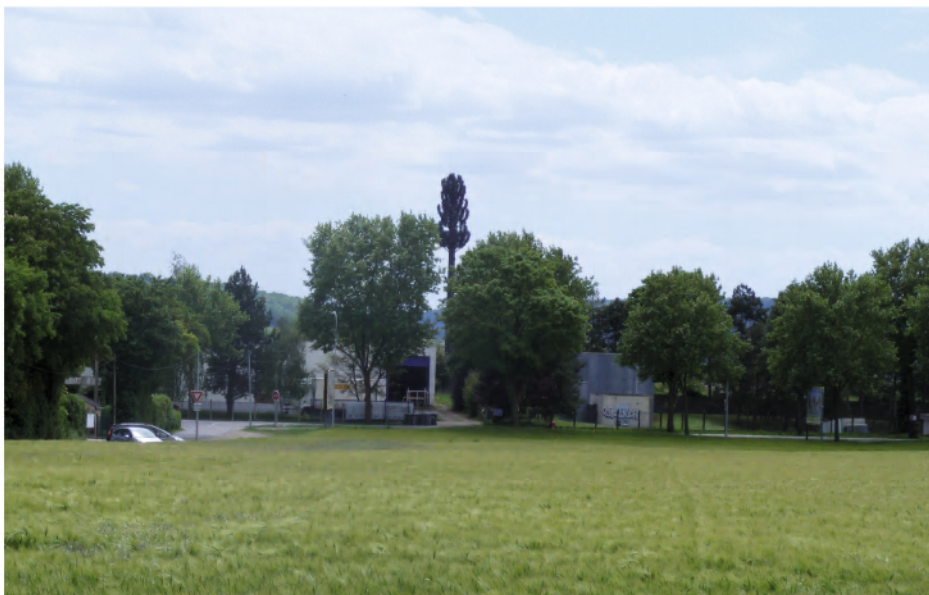
L'antenne G.S.M-R (Global System Mobile communication for Railways) pour le compte de R.F.F. (Réseau Ferré de France).
