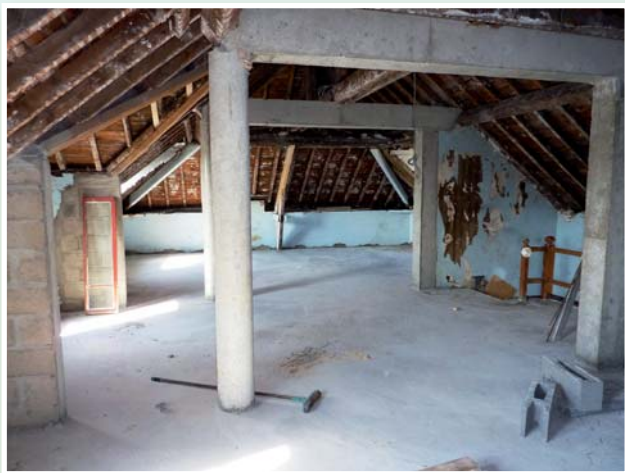
Aménagement du Pavillon Paul DOUCET L'atelier des peintres
