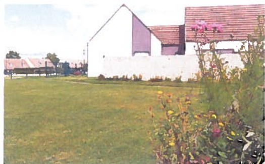
Les travaux devraient débuter cet automne pour la construction d'un bâtiment de 230 m 2 au sol adjacent à l'école des Tournesols.
